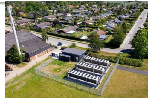
1 MW Luftwärmepumpe (Urheber: PlanEnerg)
