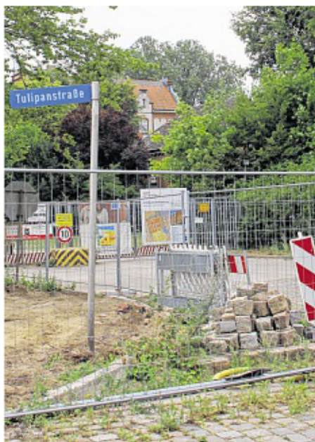
In der Tulipanstraße beginnen heute Umgestaltungsarbeiten. Sie werden voraussichtlich bis Oktober andauern.
