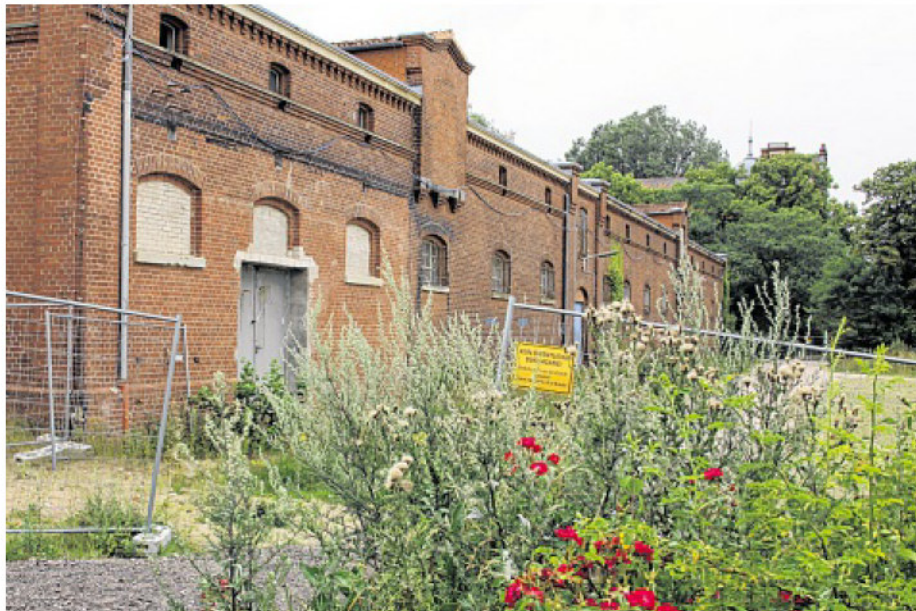
Der momentane Anblick: Unkraut, Bauzaun und verfallene Gebäude.
