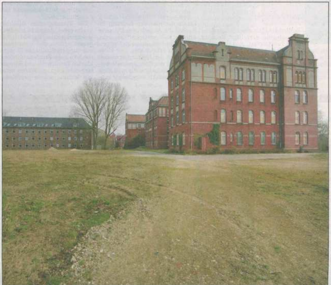
Das sogenannte Eiderschlösschen gehört zu den markantesten Gebäuden. Es steht unter Denkmalschutz.
