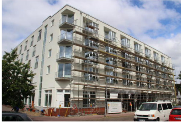
Das Hotel Conventgarten baut gerade 32 neue Doppelzimmer. © Malte Kühl
