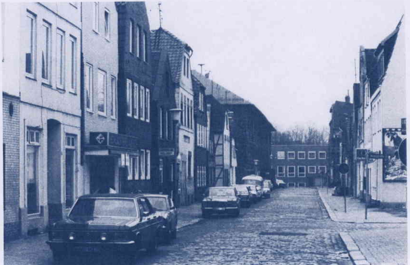
Geradliniger Verlauf der Bauflucht in der Obereiderstraße (Neuwerk).
