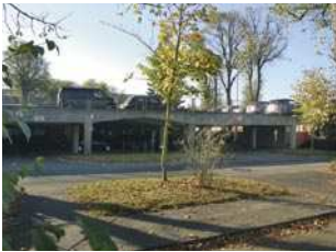
2.4.7.02 Parkdeck neben der Feuerwehr
