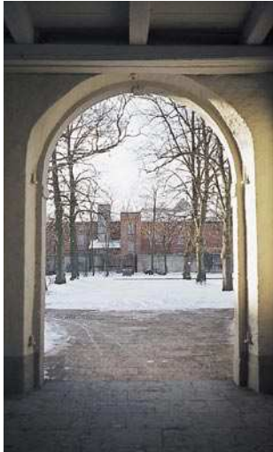
2.4.3.01 Portal Niederes Arsenal (D) Blick gegen das Hohe Arsenal (D), hier noch als verbauter Teil der Kaserne unzugänglich abgesperrt.
