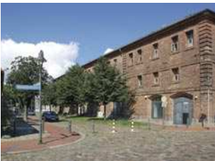
2.4.4.03 Ehemaliges Provianthaus (D)(BV)(M/N) nachher Hier liegt es an der jetzt völlig beruhigten und begrünten Provianthausstraße.
