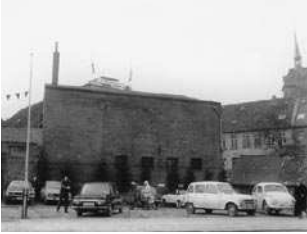
2.4.8.01 Eisenbahnstraße zwischen Am Holstentor und Stegen- graben vorher Grundstück Eisenbahnstr. 7 im Zustand um 1970 vor der Neu- ordnung, rechts am Bildrand die Marienkirche.
