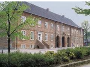
2.4.4.04 Pellihof (D)(M) Am Jungfernstieg 19 Hauptfassade nach Instandsetzung und Modernisierung.
