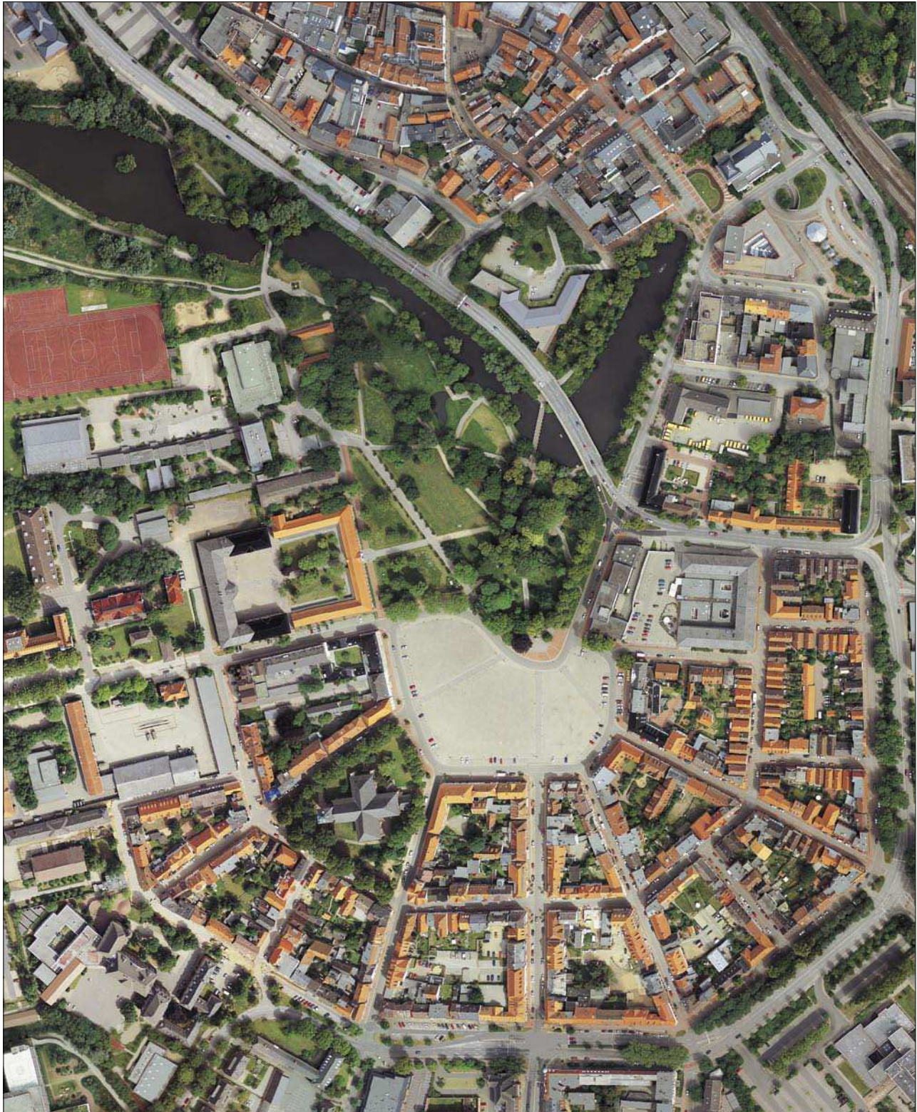
I.III „Neuwerk“ aus der Luft, schon zu wesentlichen Teilen saniert, 1996
