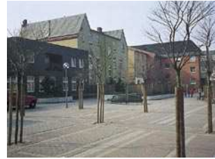
2.4.9.04 Freiraum an der Altentagesstätte (N/M) Der neuen Wohnbebauung zugewandt: Beispiel der engen Verbindung von Neubebauung und modernisierter Randbebauung an der Gerhardstraße.
