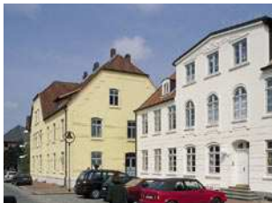
2.4.5.02 Tulipanstr. 10 (D)(M) ehemaliges Kreisbauamt nachher
