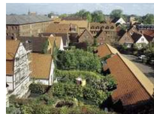
2.4.5.23 Blockinnenfläche (N) (Block 32) Das durchgrünte und mit Garagen und offenen Stellplätzen gestaltete Blockinnere an der Obereiderstraße.
