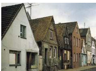
2.4.5.21 Obereiderstr. 6 bis 10 (K) vorher
