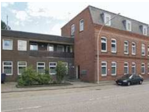
2.4.9.03 Altentagesstätte (N/M) Teil der erhaltenen Randbebauung Gerhardstr. 10 (N) und 12 (M).
