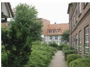
2.4.5.20 Prinzessinstr. 21 (D)(M) nachher Durchgrünte Hofseite neben der Prinzessinstr. 20 (K)(M) und 20 a/b (N) (Hofbebauung): Blick gegen die Rückseite von Paradeplatz 4, eines der vielen Beispiele für das verbesserte Wohnumfeld.
