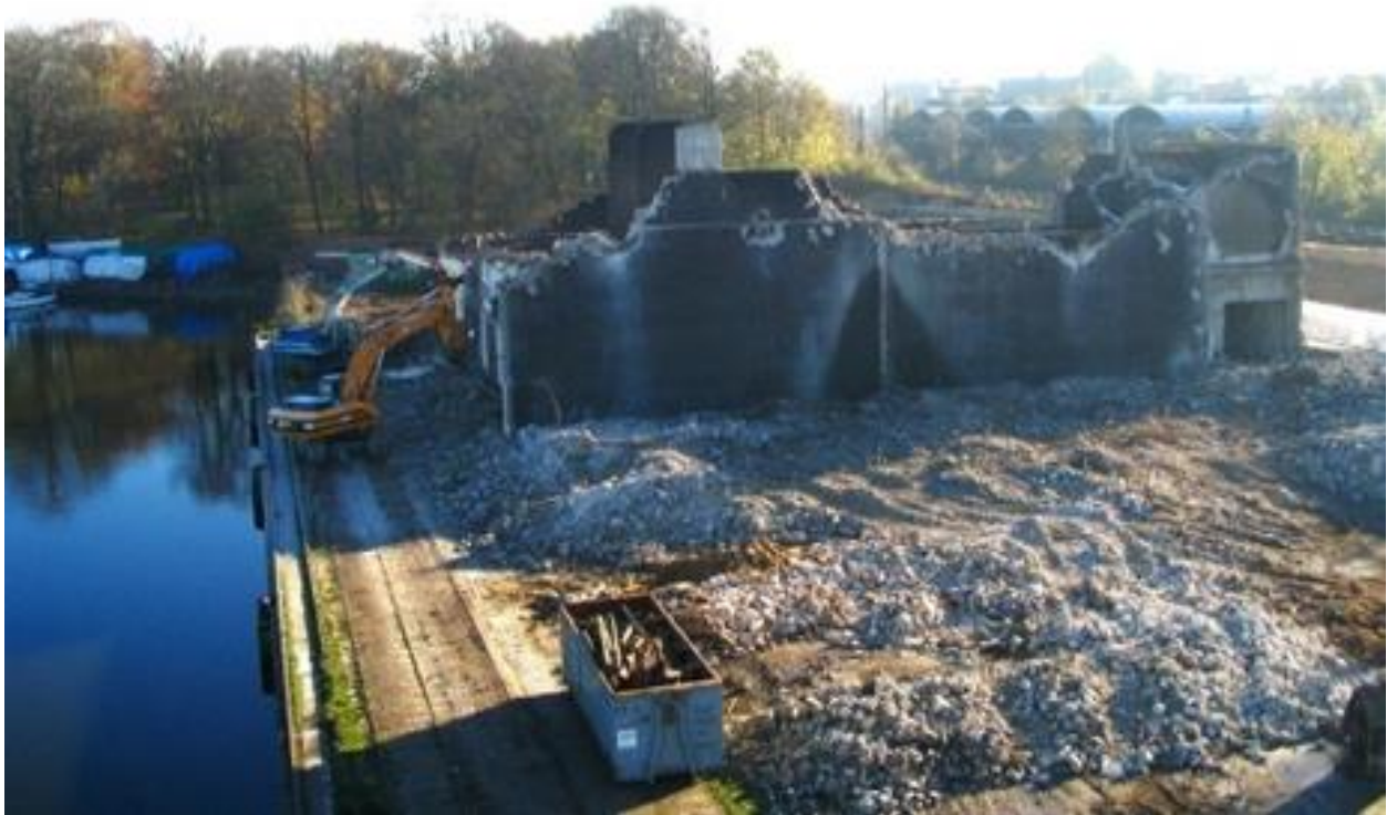
Abbruch des Landhandelsbetriebs, November 2005
