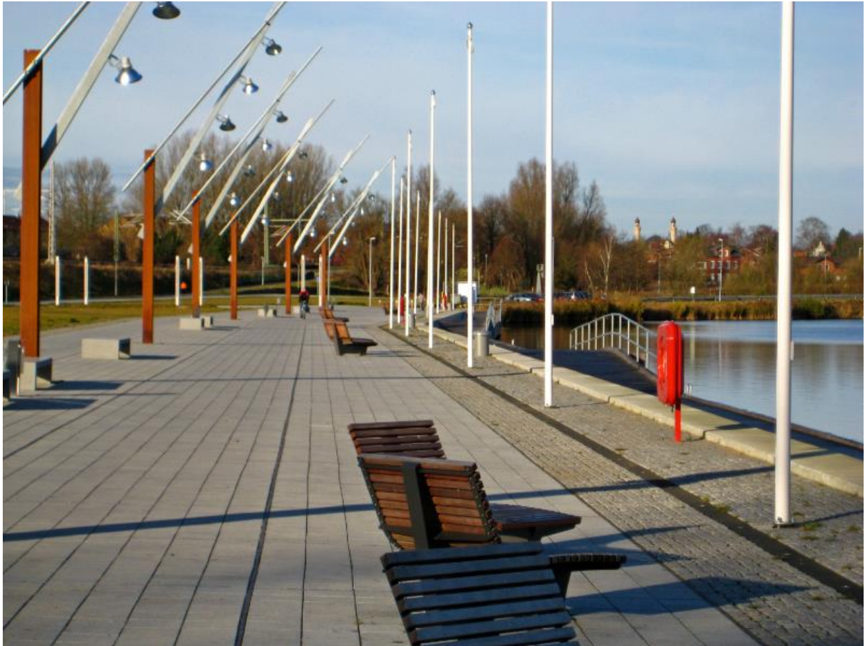
Fertiggestellte Kaipromenade, November 2007
