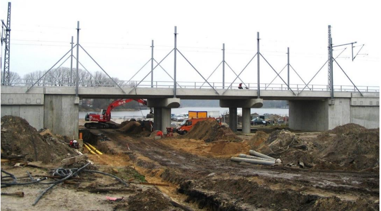
Die Bahnbrücke im Rohbau, November 2006
