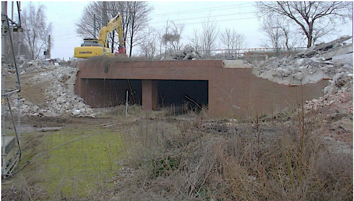
Abbildung 32 und 33: Abbruch des Parkdecks Schloßplatz, Februar 2006
