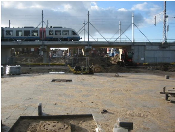
Bahnbrücke mit „Hafenplatz“, Bauzustand im Dezember 2006
