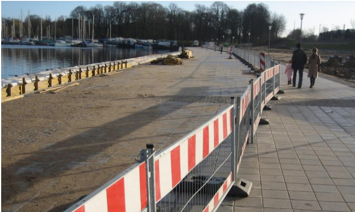
Kaipromenade, Bauzustand im Dezember 2006
