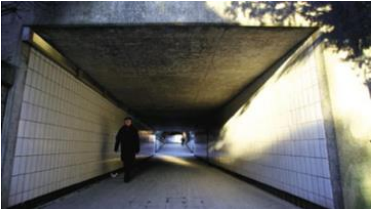
früherer Fußgängertunnel unter der Denkerstraße, 2003
