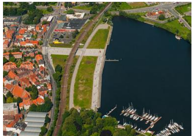
Luftbild Obereiderhafen nach Sanierung (2009)
