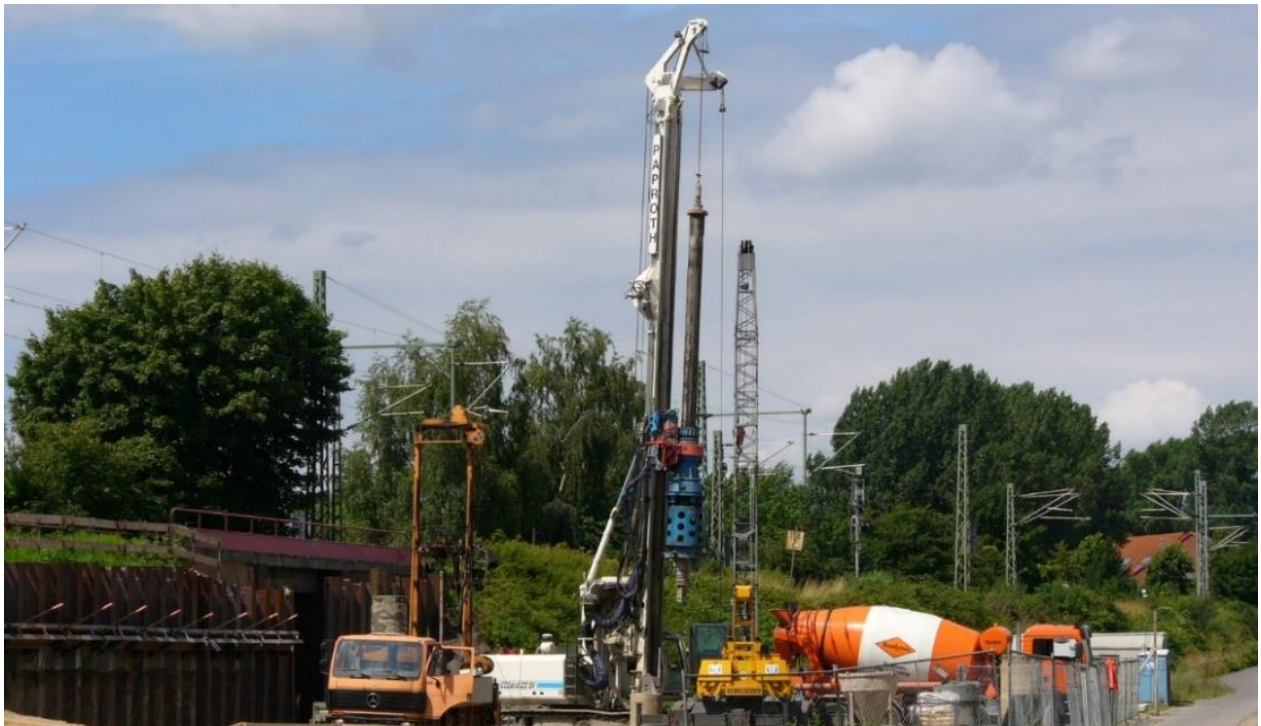
Bohrpfahlgründung der neuen Bahnbrücke, August 2005
