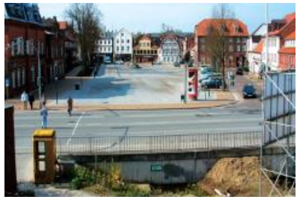
Der Schloßplatz 2004 während (schon mit verfülltem Fußgängertunnel)
