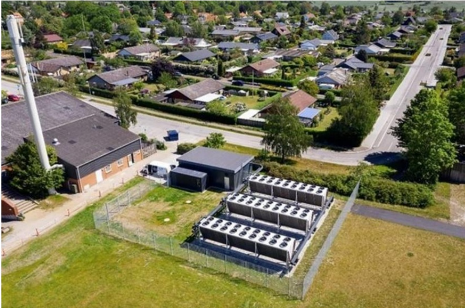
Abbildung 32: 1,2 MW Luft-Wärmepumpe in Slagslund Dänemark (Quelle: PlanEnergi)
