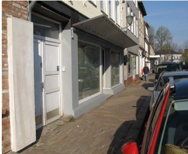
Leerstehende Gewerbeeinheit im Erdgeschoss
