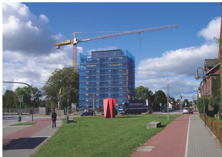
Abb. 3: Bauarbeiten an der Hollerstraße 32 im Jahr 2013
