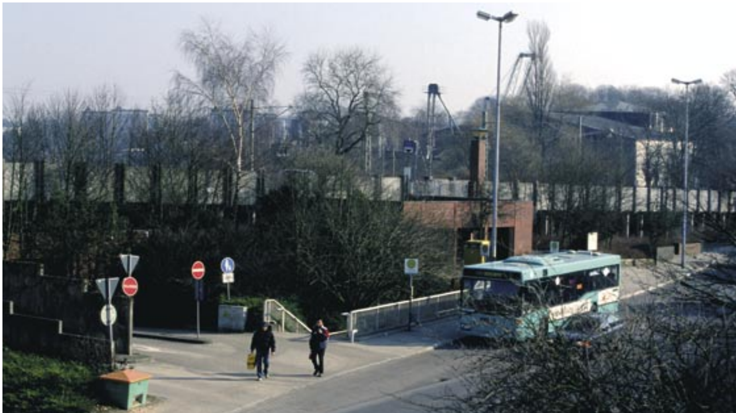
Parkdeck Schloßplatz, Blick von Nordwesten
