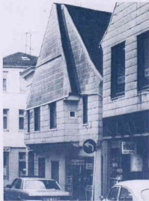
Auch das war einmal ein Fachwerkhaus! Dann wurden die Verzierungen abgeschlagen und alles unter einer grauen, gestaltlosen, aber angeblich pflegeleichten, Asbestschicht versteckt.
