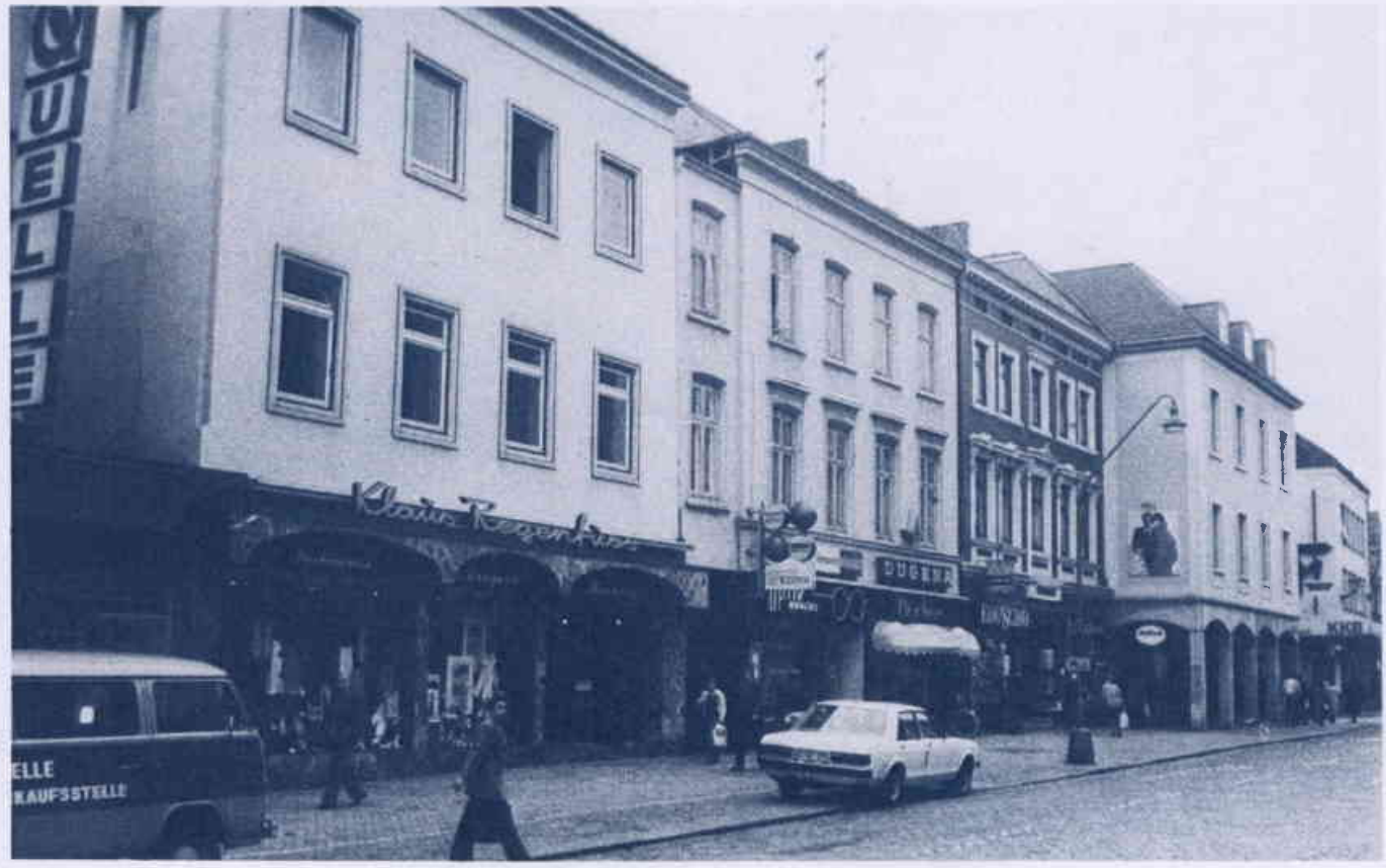
Der nachträgliche Einbau von Schaufenstern und Vordächern hat das Erdgeschoß dieser Gebäude von den Obergeschossen abgetrennt (Bild oben und unten).
