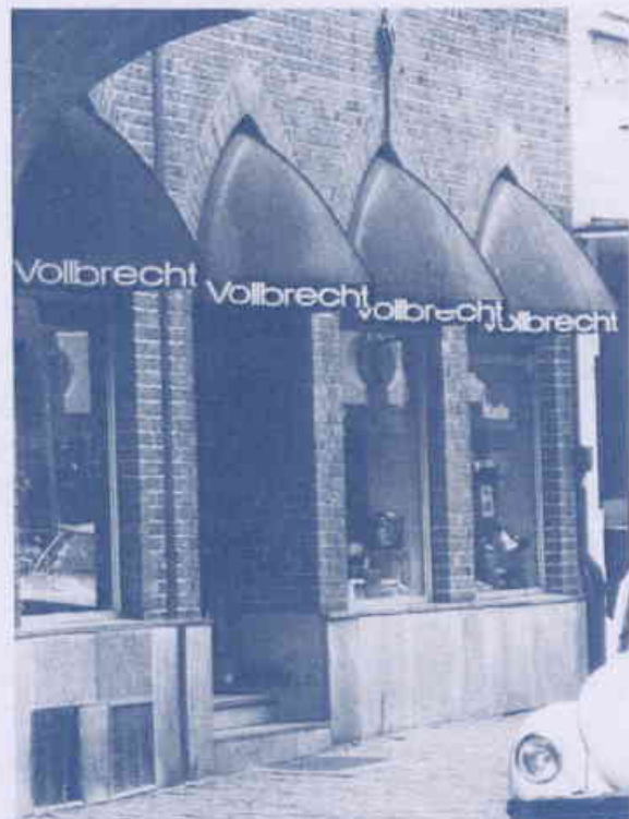
Gut gelungener Schaufenstereinbau mit modernen Mitteln. Fassadenrhythmus und gestalterische Einheit werden gewahrt.
