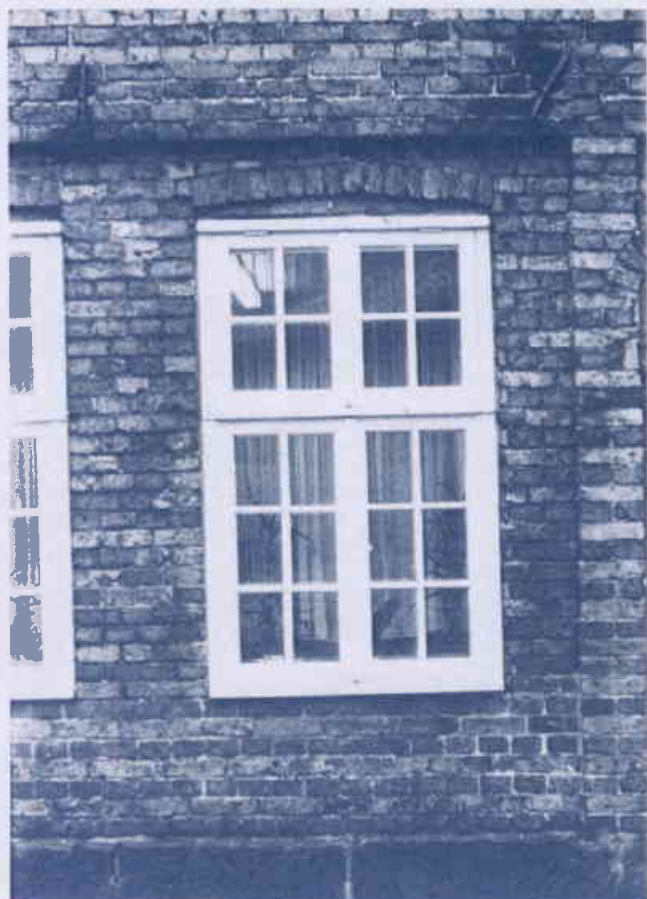
Neues Fenster, dem heimischen Stil angeglichen. Aber: Die Sprossen und das Fensterkreuz sind zu klobig dimensioniert.
