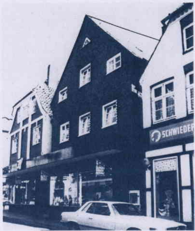
Der nachträgliche Einbau von Schaufenstern und Vordächern hat das Erdgeschoß dieser Gebäude von den Obergeschossen abgetrennt (Bild oben und unten).
