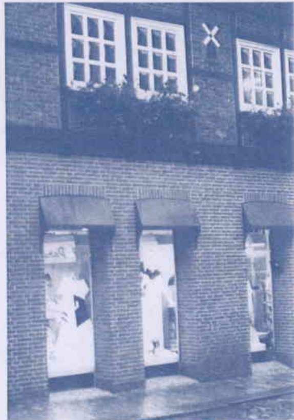
Gut gelungener Schaufenstereinbau in eine ältere Fassade.
