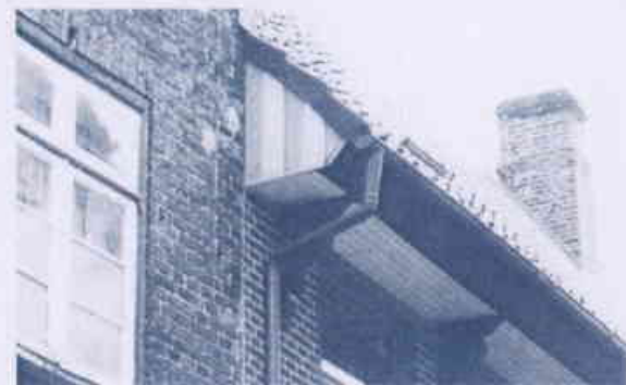
Traufgesims deutlich auskragend, reich profiliert.
