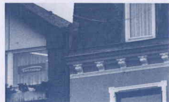
Oberer Fassadenabschluß bei einem Mansarddach.
