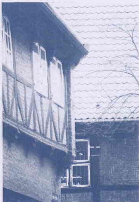
Eine historische Fassade. Beachten Sie, wie die Ausfachungen mit unterschiedlichen Klinkerlagen gemauert sind.
