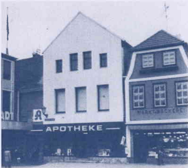
Marmorfassade über abgelöstem Erdgeschoß – eine nicht ortsübliche Fassadengestaltung
