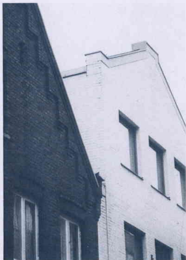
Der obere Fassadenabschluß wird plastisch ausgebildet und über den Ortgang hochgezogen.
