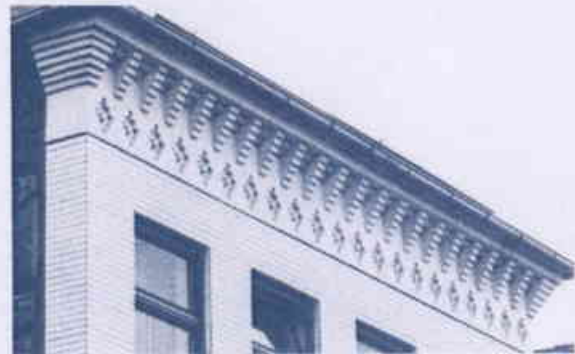
Attikatype mit reich geschmückter, weit auskragender Attika als oberer Fassadenabschluß.
