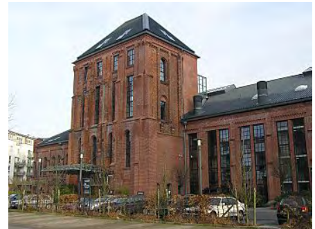
Abb. 35: Gutes Beispiel aus Hamburg. Ehemaliges Gaswerkgelände Bahrenfeld.
