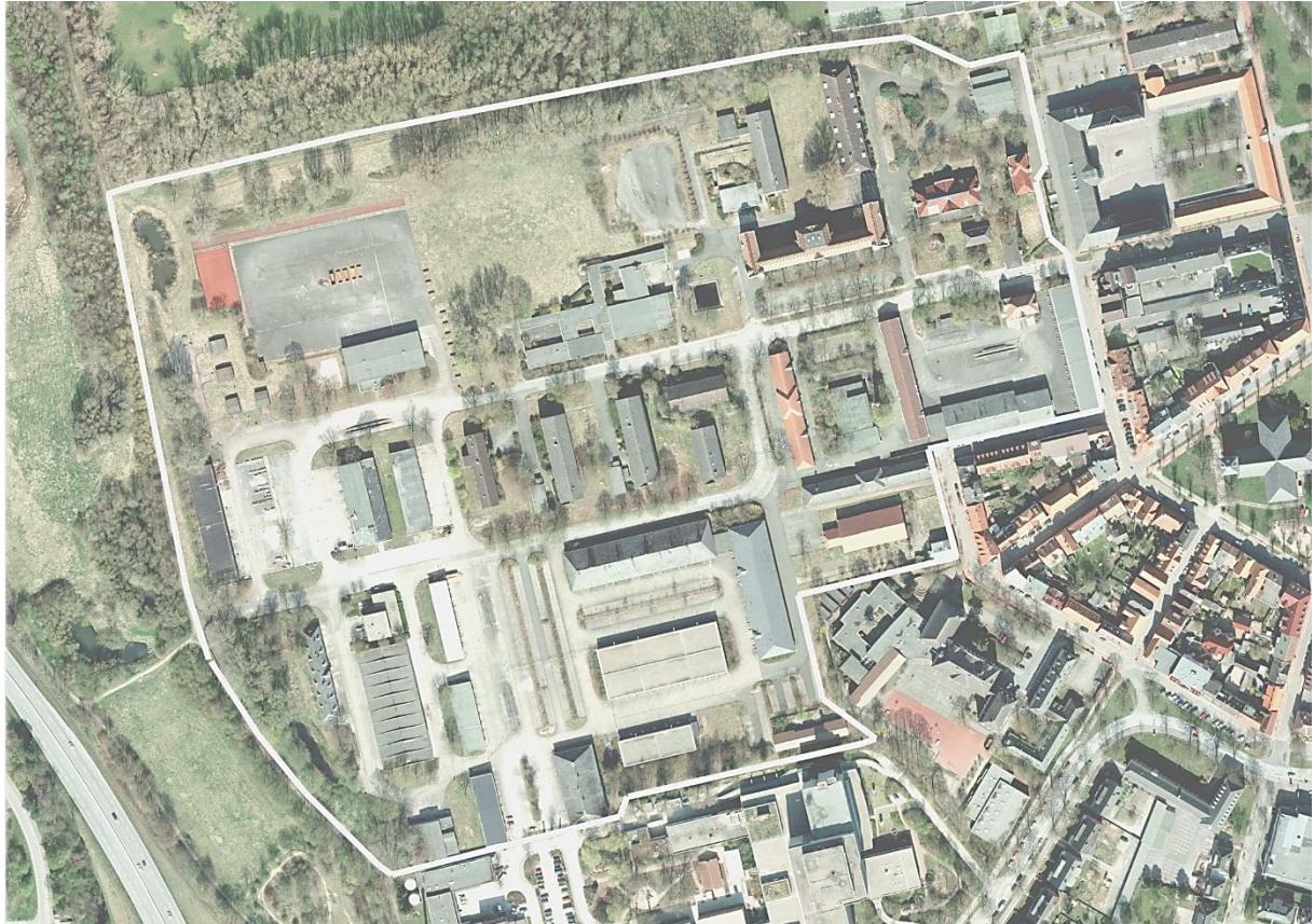
Abbildung 10: Luftbild Eiderkaserne – Bestandssituation am 09.04.2009, vor Beginn der Sanierungsarbeiten (Quelle: Stadt Rendsburg 2017, verändert durch ISR, 2018)
