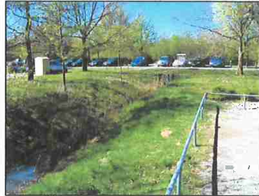
Grabenbereich mit Vorfluter mit Blick auf die Straße „An der Untereider“ nach Norden
